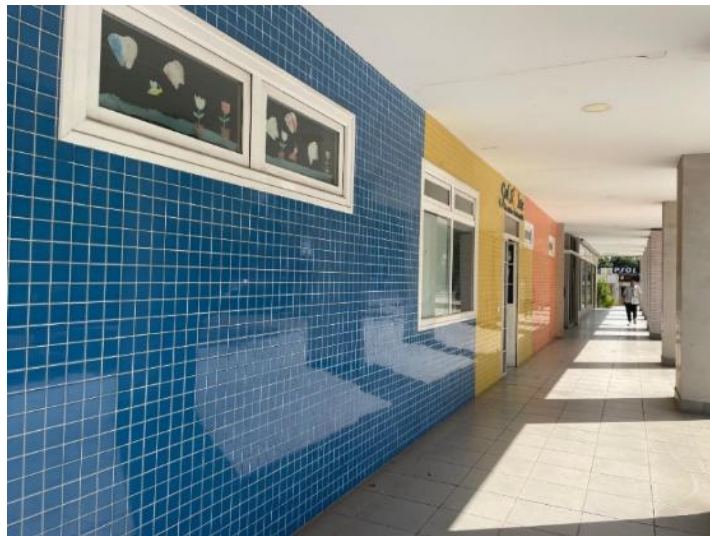
Imagen 6. Fachada principal de la edificación En primer plano, local comercial (guardería) Al fondo, local existente Centro Asistencial MC Mutual
