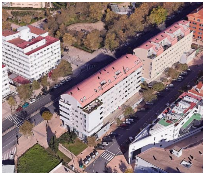
Imagen 9. Vista aérea de la edificación, donde aparece en esquina inferior el actual Centro MC Mutual y el patio trasero de uso privado
